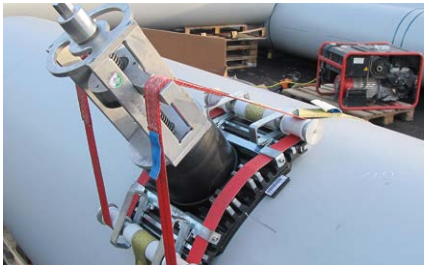
Aufspannen des Sattels ASA UNI mittels des UNITOPS
