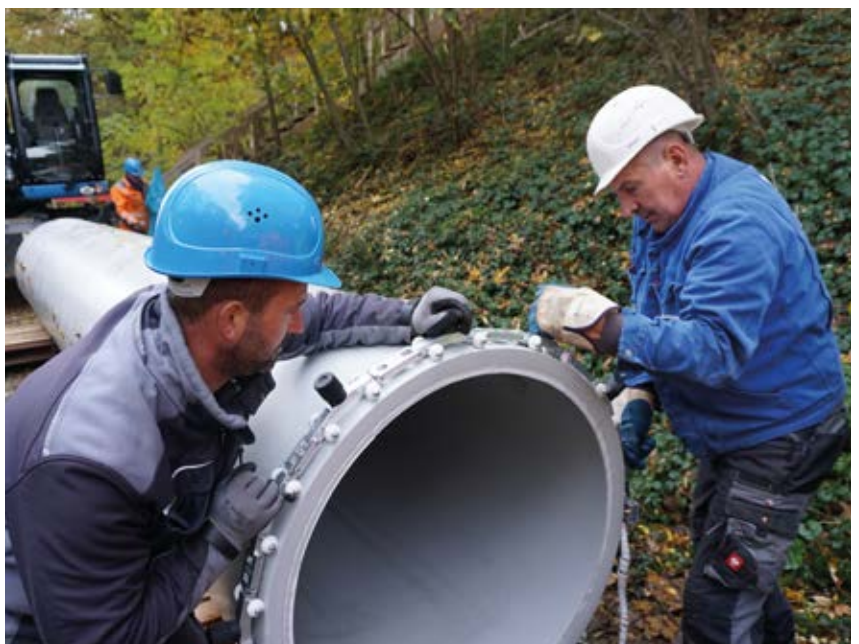
Schälen des Rohrs mit der Schälkette FWKS
